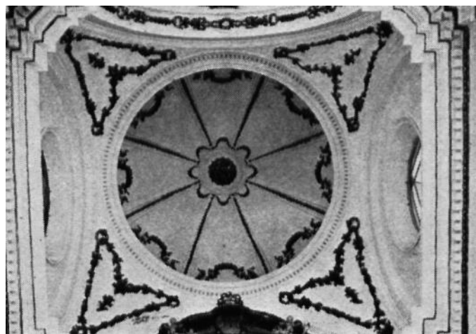
Lám. IV.—Bóveda del presbiterio. Iglesia de las Dominicas en calle Andrés Pérez
